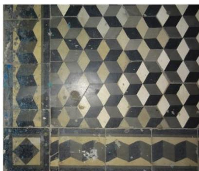
*Рис. 14. Цементная плитка квадратной формы по периметру и гексагональной формы в парадной со стороны ул. Свердлова*
