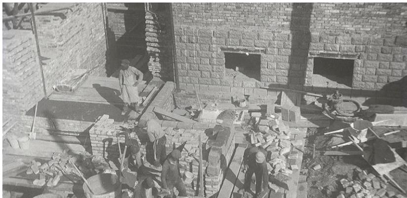
*Рис. 6. Возведение цокольной части фасада по ул. Шелгунова (просматривается кирпичная кладка и ряд полнотельных бетонных блоков). Фотография 1928 г. из частного собрания С. Ю. Степанова*
