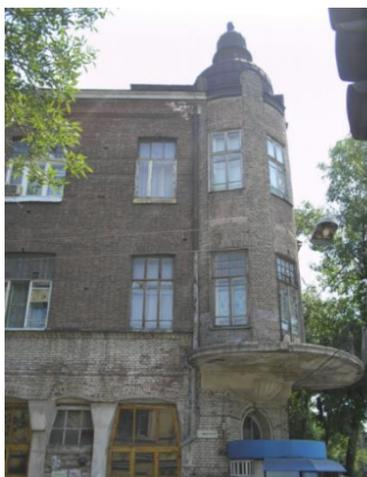
*Рис. 15. Фрагмент фасада по ул. Коммунистической с подлинными столярными заполнениями оконных проемов второго и третьего этажей и балконного дверного проема. Фотография Т. О. Цитман, 18.07.2006*
